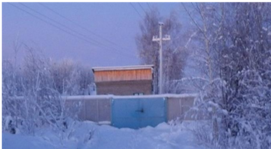
Рисунок 3.4.4 - Здание скважины с насосной станцией во второй технологической зоне
